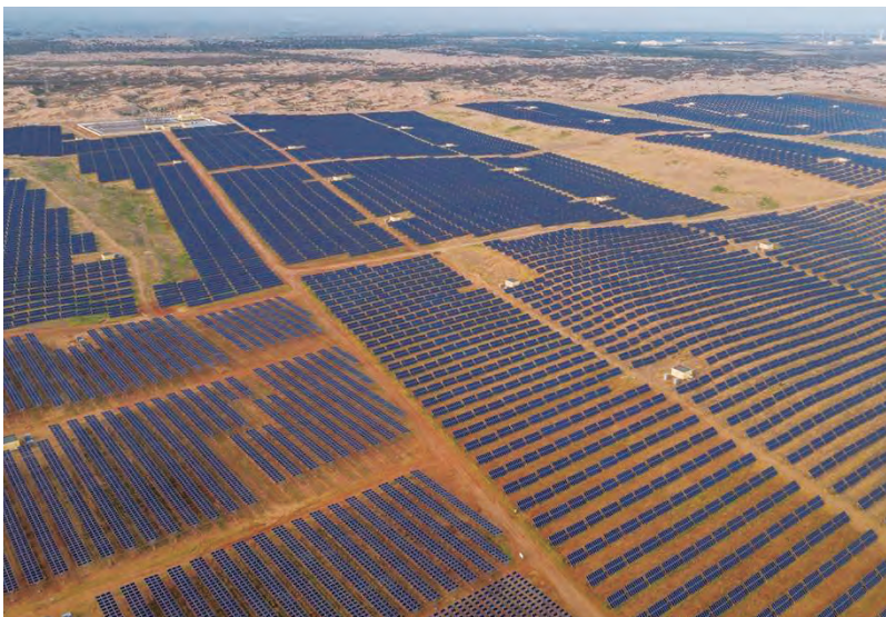
沙漠变太阳能光伏电站
