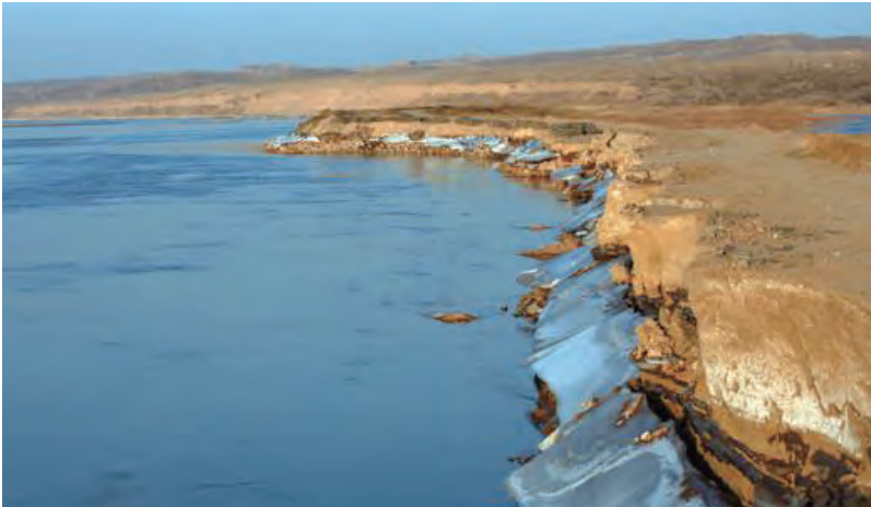
图2 黄河(内蒙古段)开河期河岸坍塌
